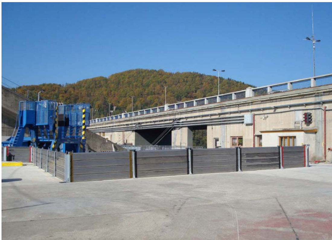
Obr. 4. Hliníková hradítka na platě hráze kolem horní části výtahu pro sportovní plavbu [23]
