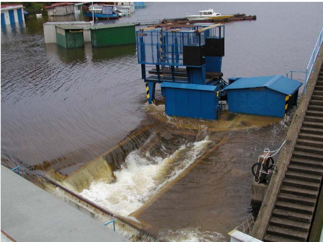
Obr. 2. Průběh povodně 2002, překročení maximální projektované hladiny o cca 1,5 m (voda přetékající přes plato hráze do lodního výtahu)[23]
