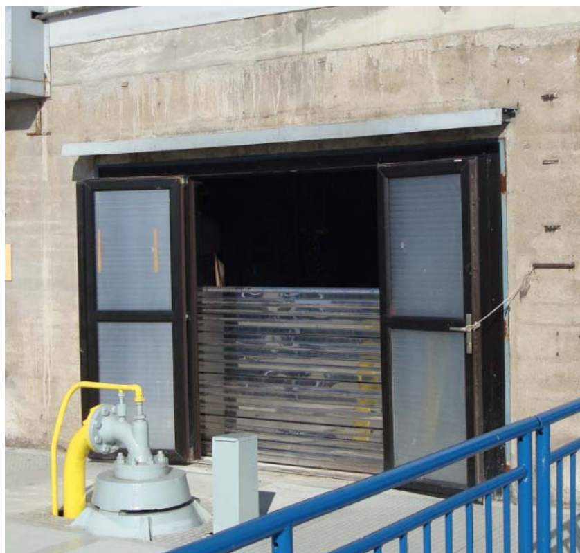
Obr. 5. Hliníková hradička instalovaná ve vstupním otvoru do manipulačních prostor v tělese hráze VD Orlík [23]
