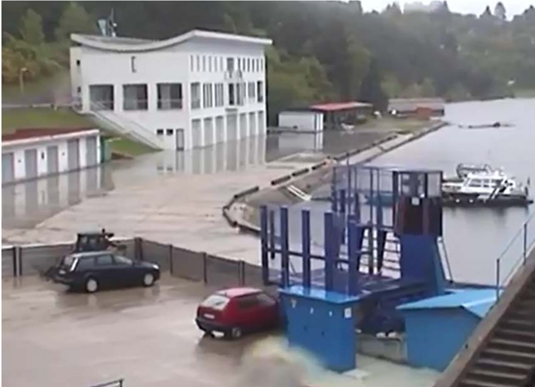
Obr. 3. Průběh povodně 2013 (instalovaná hliníková hradítka na platě hráze; během povodně nedošlo k překročení H_{max} )[43]
